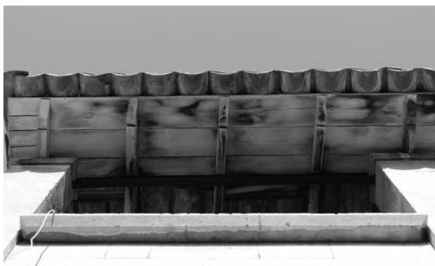
Carrer Rector Llompart, 10. Volada d'una porxada, les bigues descansen sobre una jàssera de ferro coberta de teules sobre posts.
