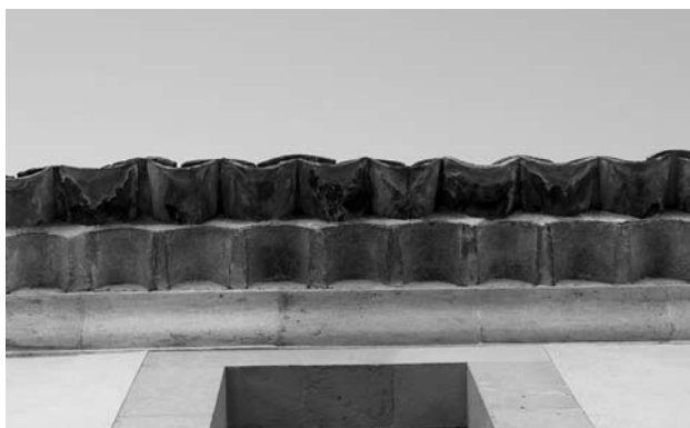
Carrer d'en Lluís, 32. Volada feta amb dues filades de teules sobremuntades sobre una motllura de marès.
