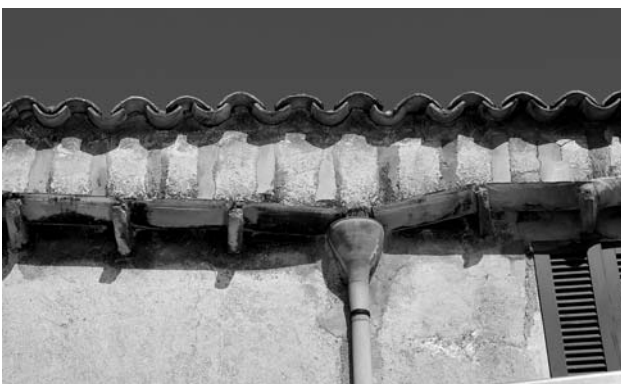
Corral al carrer Nou. Volada simple amb teules incrustades al morter del parament, la recollida d'aigües es fa amb teules posades de caire i una arqueta ceràmica.
