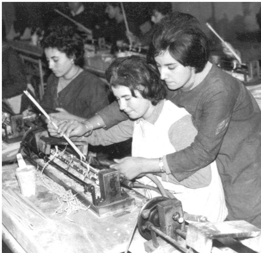
Antònia Mas Mora ensenyant a utilitzar la màquina de fer bolla a Antònia Veny Martorell Molleta. Dècada dels 60.
