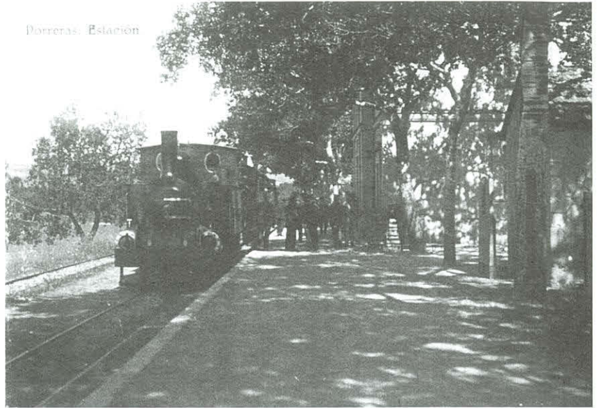
Els edificis de l'estació de Porreres representaren al seu dia una innovació arquitectònica.
