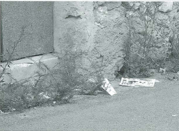
Una casa deshabitada. A qui correspon la neteja de la vorera?
