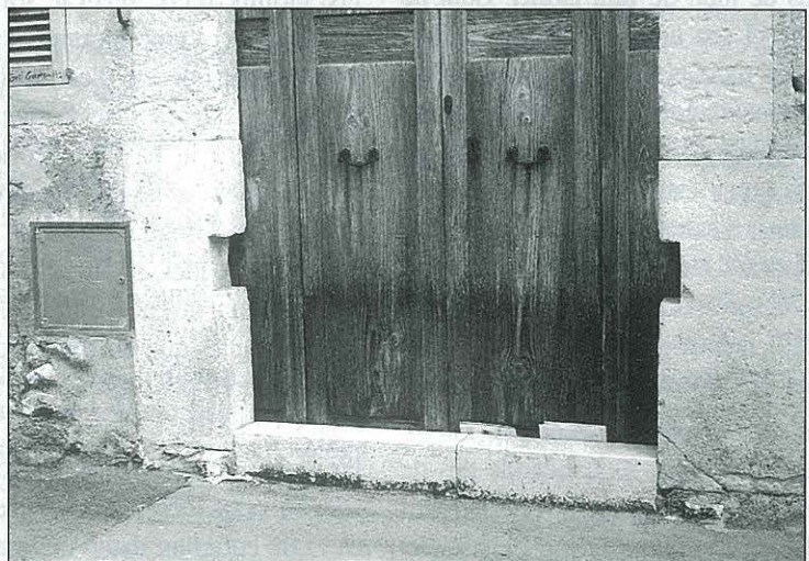
Carrer Tort. Ca madó Maria Renya . És interessant destacar les dues endinsades laterals del portal, per facilitar el pas del carro. Així, la cuba de la roda no feia malbé al brancal del portal forà.
